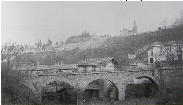
Traversée de la rue Pierre AUDRY.
